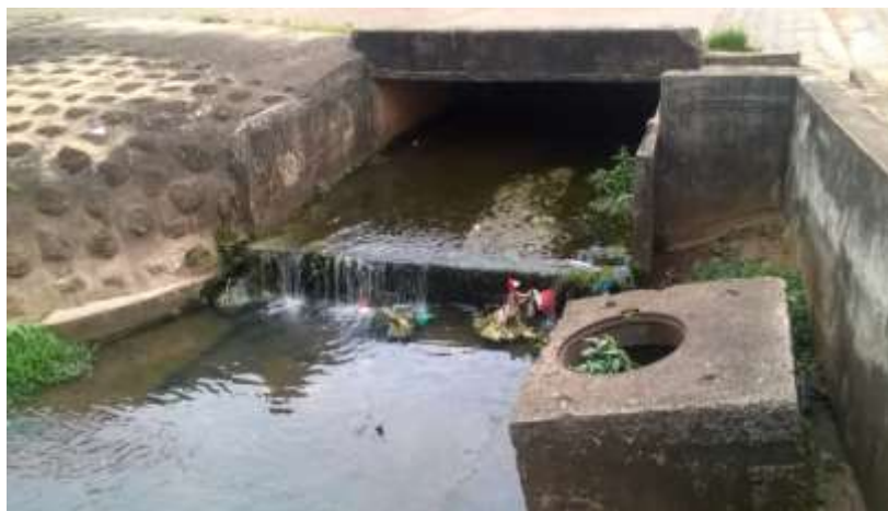
Photo 1 : Un canal de drainage des eaux à ciel ouvert dans un quartier d'Akanda
