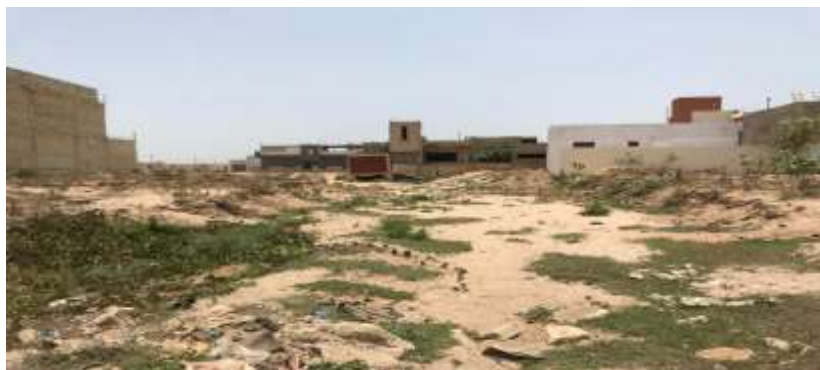
Photo 2 : Image de bâtiment construit dans l'emprise de l'eau
