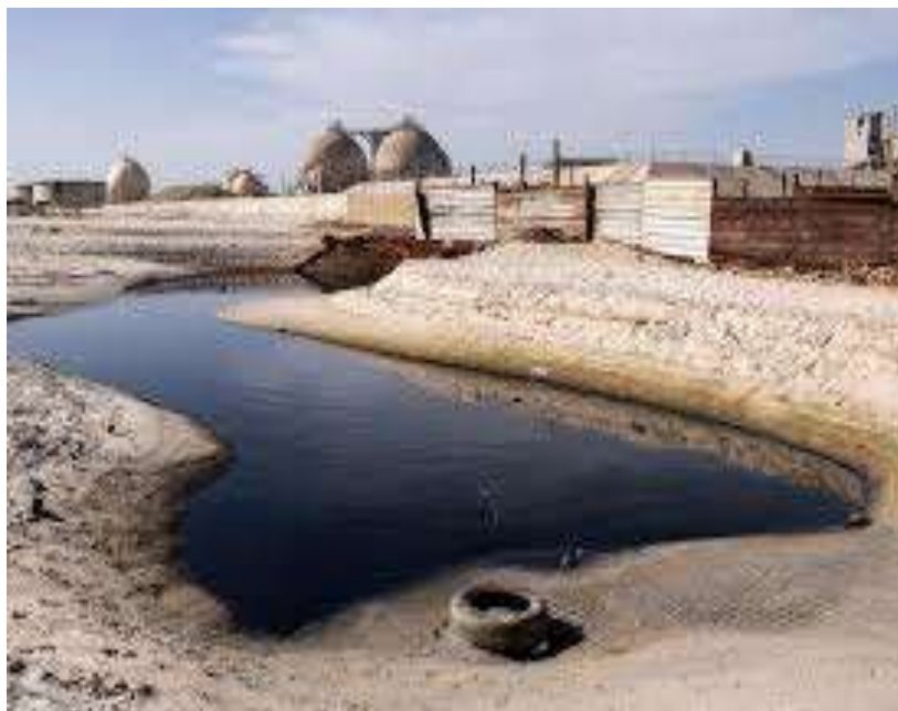
Photo 1 : Ruissellement des eaux usées industrielles vers la baie de Hann
