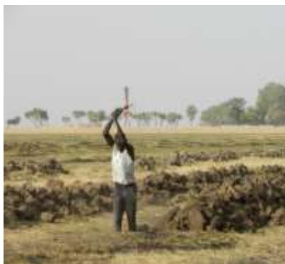
Travaux de construction d'une diguette à Maga
