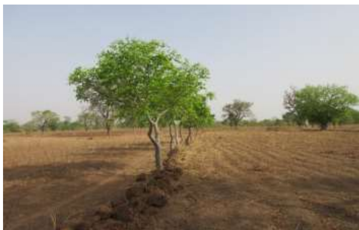
Figure 3: Aménagement d'un cordon pierreux dans une parcelle agricole à Tambiri
