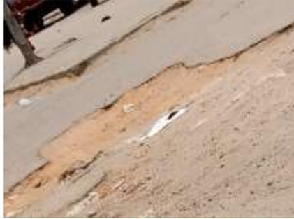
**Figure 6** : Une partie dégradée de la RN9
