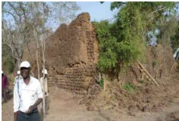
Photo A : Fissure de l'angle nord-est de la muraille principale de la bâtisse en ruines de Loropéni
