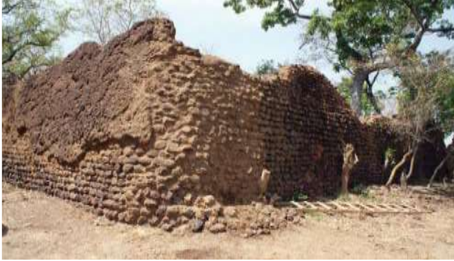
Photo B : Le même angle nord-est après une action de rejointoiement
