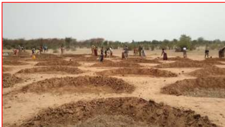
Photo 1. Construction des demi-lunes, barrière aux ruissellements
