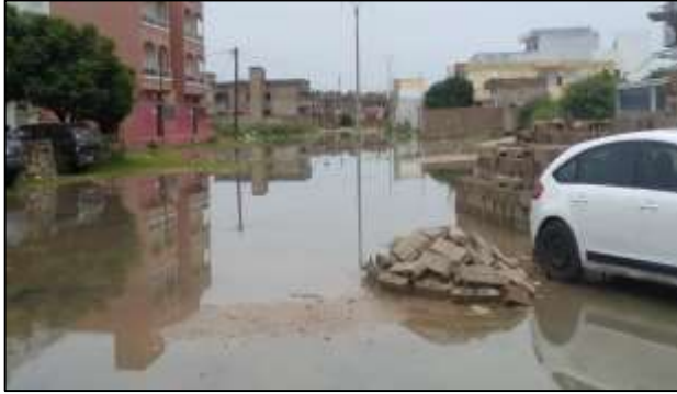
Photo 4 : Inondation des rues suite à l'artificialisation du sol sans réseau d'assainissement. (Septembre, 2023)
