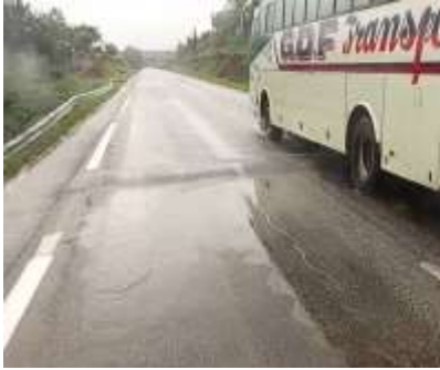
Photo 1 : Un ralentisseur entrée sud du village de Yakassé-Mé
