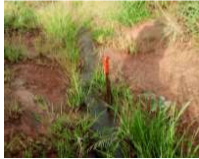
Photo 3 : Matériau du fond de la digue
