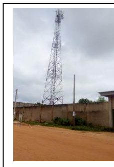
Photo 1 : Pylône MOOV AFRICA
