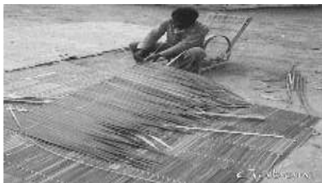
Figure 4 : Confection d'une toiture en feuilles de paille
