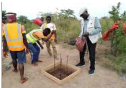
Photo 5 : Construction d'une borne frontière intermédiaire par les experts de la CTM, prise de vue, F. Ndzani, juin 2023
