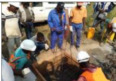
Photo 6 : construction d'une borne frontière principale par les experts de la CTM, prise de vue, F. Ndzani, juin 2023
