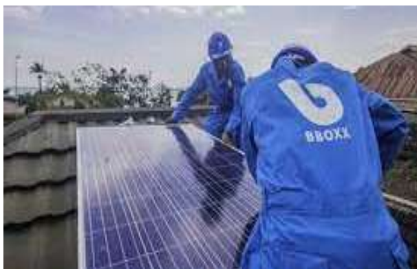
Photo 3 : Panneaux solaires sur les toits des logements à Lêgbassito Installation faite par la société BBOXX
