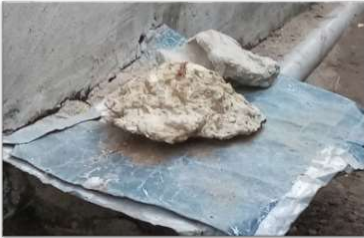
Photo1 : Dispositif utilisé pour l'évacuation des eaux usées Prise de vue : Manouan N. M., 2021
