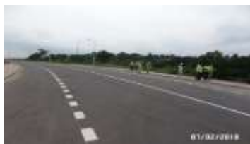
Photo 2 : Vue du deuxième tronçon giratoire du Tchad – pont du Djoué (Prise de vue Entreprise Razel. BEC, 2018)
