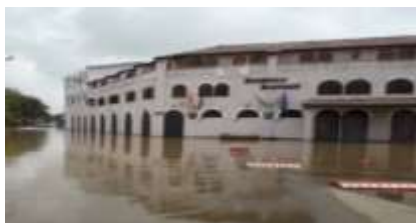
A : Inondation de la zone de la bibliothèque municipale
