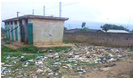
Photo n°4 : Latrine à six cabines au complexe scolaire d'Agonvè à Lokossa.
