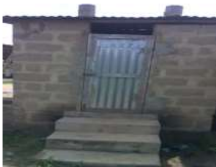
Photo n°3 : Une latrine ECOSAN bénéficiée par un ménage dans le quartier Tchicomè à Lokossa.
