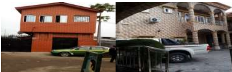
Photos : 1 : Première habitation construite ; 2 : Nouvelle habitation construite
