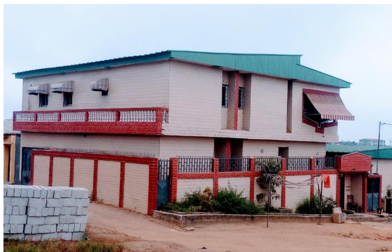
Photo 1 : Villa de haut standing sur front Ouest (quartier CEG extension)
