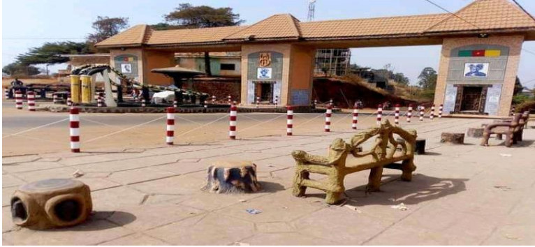
Photo 2 : La porte des Tranchées de Foumban rénovée
