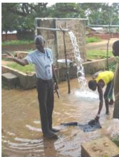
Photo 4 : Fuite de l'eau du forage artésien jaillissant de Vovocannè avant son aménagement
