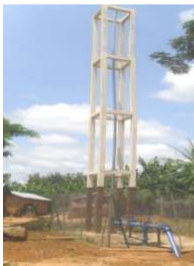
Photo 5 : Forage artésien aménagé de Vovocannè avec la maîtrise totale de l'eau
