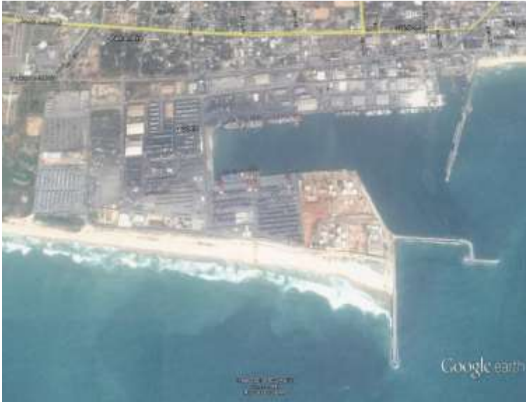
Figure 1 : Port de Cotonou et ses installations
