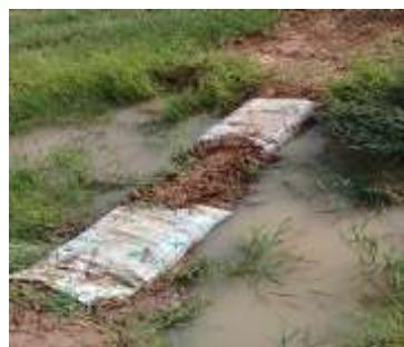
Photographie 4 : état des digues de protection d'irrigation
