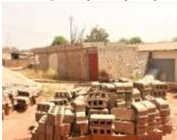
Photo 1 : Adjonction d'une maison basse sur le logement produit par l'opérateur
